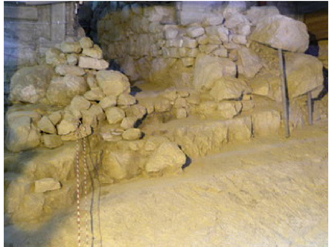
Base de la torre defensiva de la fuente de Guijon
