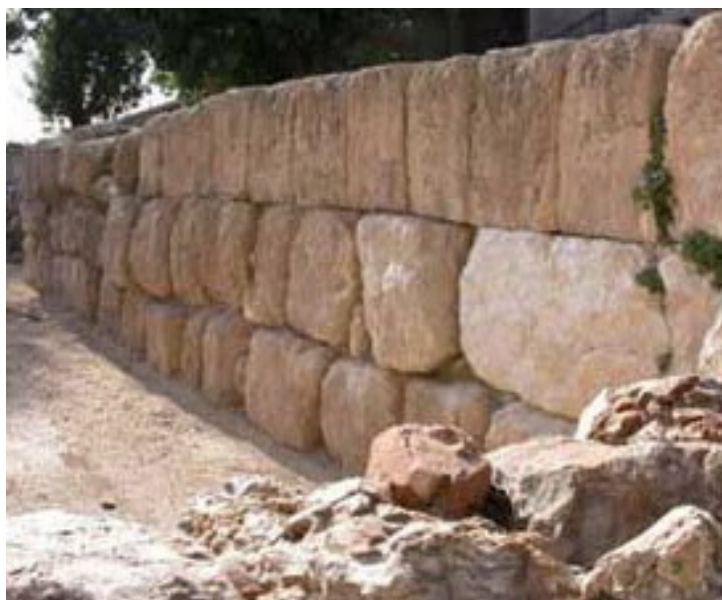
Sillería de los muros del palacio
